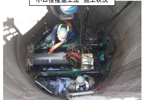
小口径推進工法 施工状況
